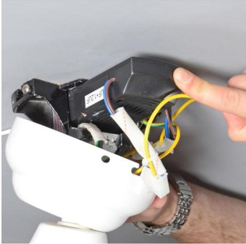
Drücken Sie den Empfänger bis in die Mitte der Halterung.
